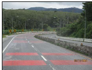
Red Anti Skid กม.1138+700 (เดิม กม.36+940) ด้านตรัง-พัทลุง
