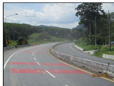
Red Anti Skid กม.1138+700 (เดิม กม.36+940) ด้านตรง-พัทลุง
