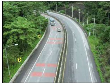
Red Anti Skid กม.1133+800 (เดิม กม.41+840) ด้านตรัง-พัทลุง
